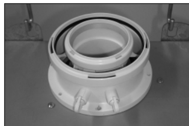
Pohled na připojovací místo s adaptérem AZB 931
