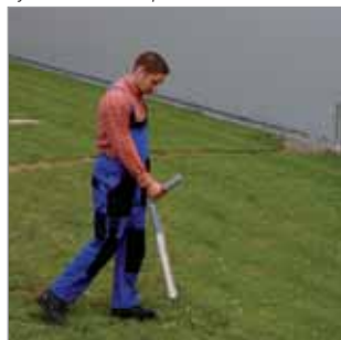
Vyhledání hlavice pod zemí
